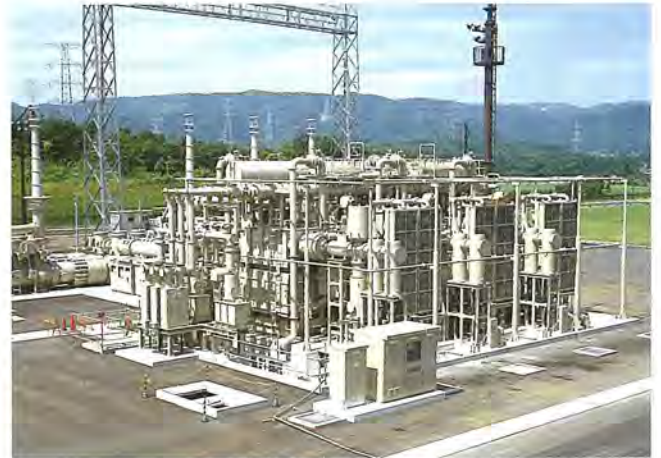
南相馬変電所納め500kV 1000MVA 変圧器
