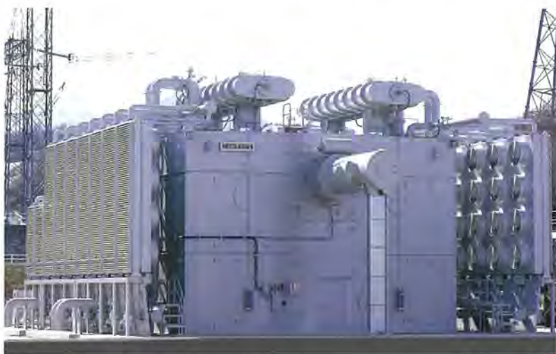
1,000kV変圧器の外観
