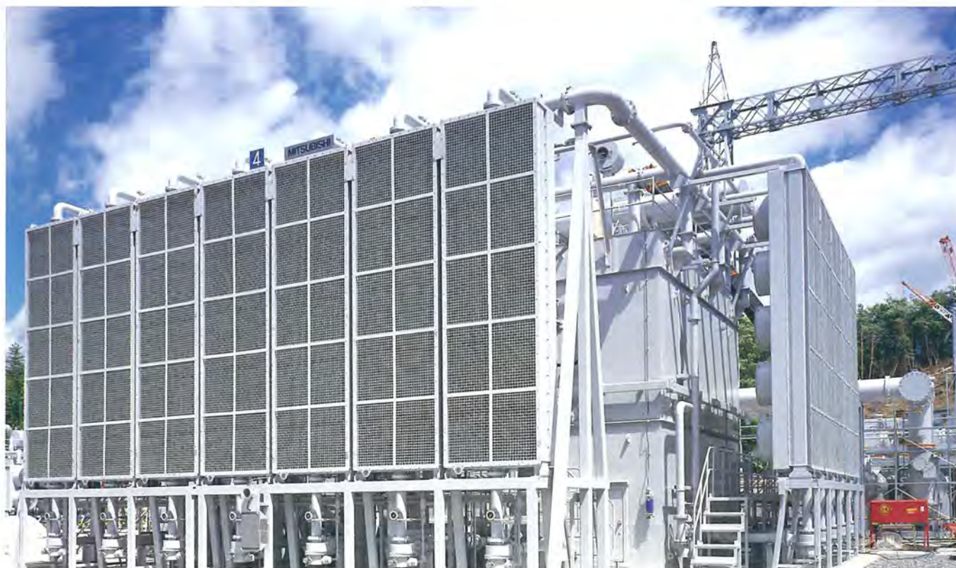
愛知変電所納め500kV 1,000MVA CGPA変圧器
