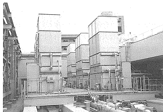
図21. 総合冷却システムの冷却塔設備
