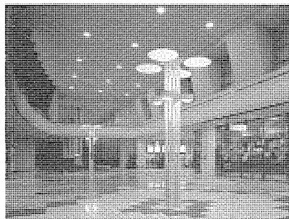
図26. JR山形駅・コンコース HQI250W×4 特注ポール塔2基 MH400Wダウンライト MH100W投光器
