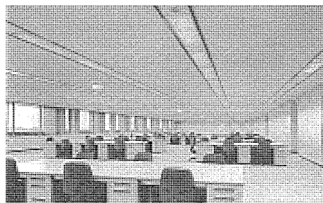
図1. 全国信用金庫連合会厚木計算センター(神奈川県)・執務室 FLR40W×2 OAルーバ システム天井用器具(システム用ファインベース) 平均照度900 lx
