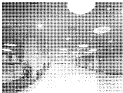
図25. JR京葉線東京駅・改札外コンコース FPL36W×6 下面アクリルカバー埋込み器具 HF200Wダウンライト
