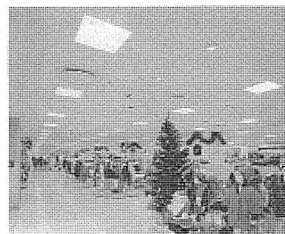
図10. 川口そごう(埼玉県)・子供フロア FPL36W×4 ルーバ付き埋込み器具
