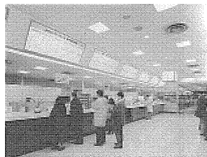
図29. JR京都駅・1階出口 FPL36W×4 ルーバ付き埋込み器具 FDL27Wダウンライト
