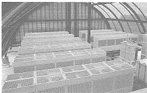
図2. トップフロータイプ室外機の集中設置例
