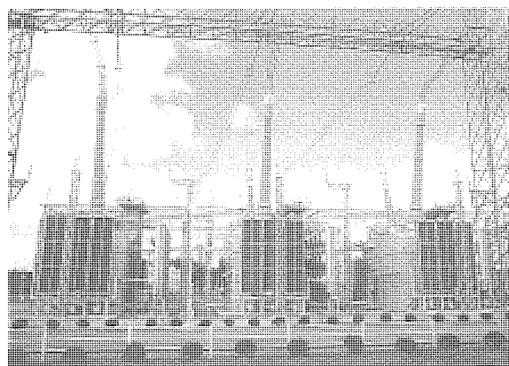
図1. 東京電力㈱新佐原変電所納入 500/275kV 1,500/3MVA単相単巻変圧器
