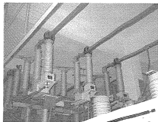
図9. 77kV気中変電所事故点標定装置用光CT
