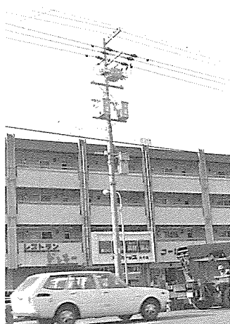
上段：開閉器 中段：子局結合装置 下段：子局
