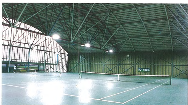
3. グリーンアカデミースポーツクラブ（福島市） グリーンアカデミースポーツクラブは、屋外テニスコート2面と屋内テニスコート3面をもつテニスクラブである。照明は、屋内・外とも同デザインの屋内用及び屋外用の1kWメタルハライドランプ用テニスコート専用の照明器具（プロラックス）を使用し、1面あたり6灯、計30灯を設置している。照度は、実測で屋外486 lx、屋内で652 lxを得ている。
