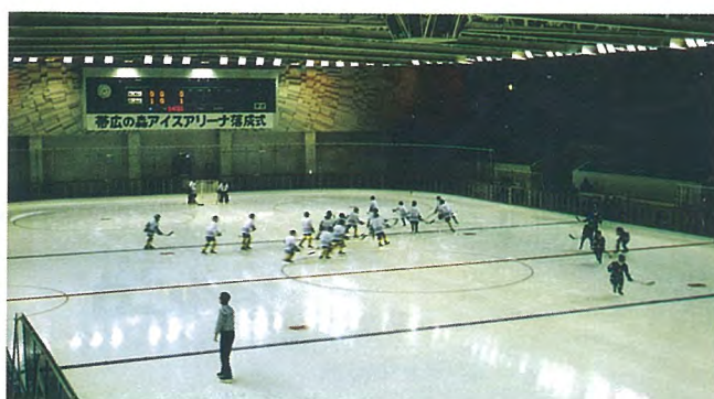
4. 帯広の森アイスアリーナ（帯広市） 帯広の森運動公園内にアイスホッケーの公式試合も可能な帯広の森アイスアリーナが完成した。照明は、30m×60mのリンク外周上部に設置したキャットウォーク全周に700Wメタルハライドランプ用角形投光器を164台配置した投光照明を採用している。また、投光器は、選手と観客にまぶしさを与えないよう黒色のルーバーを内蔵している。照度は、全点灯時アリーナ部で実測平均照度2080 lxを得ている。
