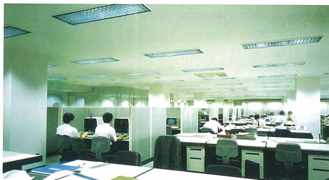
1. アイネスコミュニケーションプラザビル（川崎市） インテリジェントビルとして建設された同ビルの照明は、一般事務から高度情報処理まで多目的な事務処理に対応できることが望まれる。照明器具は、埋込下面開放形蛍光灯器具を基本形とし、使用目的に応じ遮光ルーバーなどの各種オプションを取揃えたファインベースを採用している。写真は、システム開発フロアの照明で、OAルーバーのオプションを使用しVDT画面に写り込みのない快適な照明となっている。
