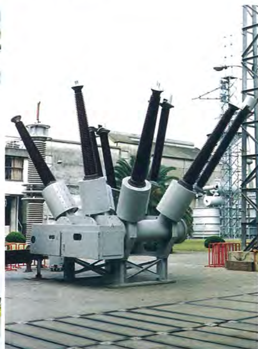
(b) 300kV 63kA一点切り SF 6 ガス遮断器
