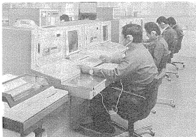
図 7. 監視センターの機器の設置状況(菱電サービス(株)情報センター)
