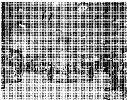
図 5. 東京・小田急百貨店別館「ハルク」1階売場の照明 (250 W 《BOC ランプ》, 200 W 電球の混光照明で、初期平均照度 650 lx)
