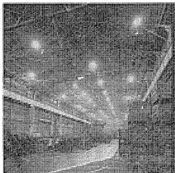
図 6. 愛知・三菱重工業(株)名古屋精機製作所鍛造工場の照明 (360 W 演色性改善形高圧ナトリウムランプと 400 W 高圧水銀ランプの混光照明で初期照度 150~300 lx)
