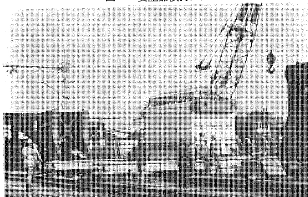
図 5. 変圧器横持装置の使用状況
