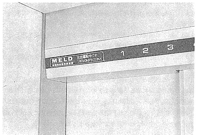
図 4. 《MELD》運転表示装置（かご出入口上部設置）
