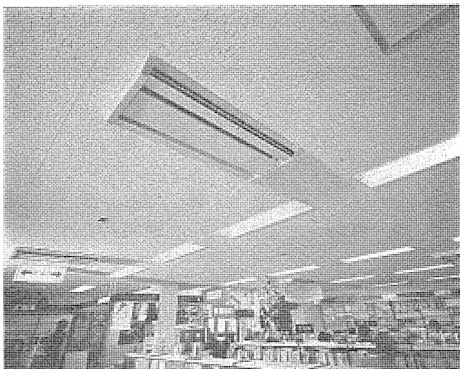
図1. カセット形ファンコイルユニット据付例
