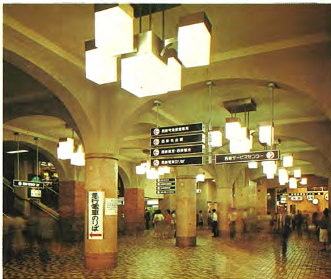
4. 西鉄・福岡駅コンコース (福岡) このコンコースは従前けい光灯照明であったが、既設の配線はそのままにして、水銀灯照明で歩行者が安全に通行できる十分な明るさが得られるよう「LLCBシステム」を使用した。器具は250Wけい光水銀ランプ×1灯と200Wけい光水銀ランプ4灯をシャンデリアタイプの器具にまとめ(グロープは乳白色アクリル、下面アクリエッジルーバー付き)1スパンに1灯ずつ計9台取付け平均照度500lxである。
