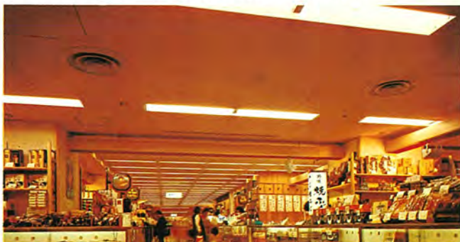
6. (株)井筒屋、地階食料品売場 (福岡) 北九州市小倉の繁華街にあるこのデパートは、店内外の全面的な改装を行い一新した。照明は全般照明にけい光灯40W×1灯半埋込み、側板アルミ押出し成形材を使用した器具で、スッキリとした明るいライン照明をつくり出している。なお周辺部にはけい光灯40W×2灯2連埋込み下面開放形器具が設置され、けい光ランプはすべて演色性のすぐれた「ハイドラックス」が使用され、商品の色が自然の色に見えるお客様にも店員にも好評である。照度は1,000lx。
