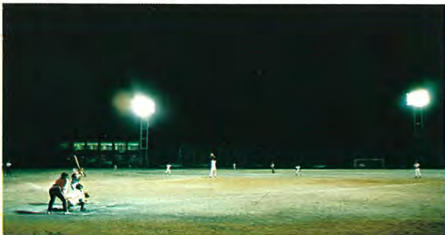
5. 中津川市民グラウンド (岐阜) 地域住民の余暇の有効利用、体力増強のため作られた市民球場で、広さはホームベースからセンター後方まで約100m、両翼約90mである。グラウンドはメタルハライドランプ「BOCランプ」1,000W投光器計96台を4基の鉄塔(平均器具取付高さ18.6m)に設置している。高効率・高演色性のBOCランプによるさわやかな照明下で気持ちのよいプレーが行なわれている。照度は内野480lx、外野280lx。
