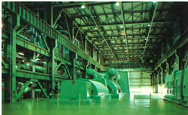
2. 関西電力(株)多奈川第2火力発電所。 昭和52年7号1号機(出力60万kW)の営業運転に入ったこの発電所は、夏場の電力需要のピンチを回避させたといわれている。照明はけい光水銀灯1,000W反射かさ形器具24台と電球1,000W4台が設置されている。設計平均照度は200lxである。なおボイラータワー、中央制御室など屋内屋外を含めて多数の照明器具が納入されている。
