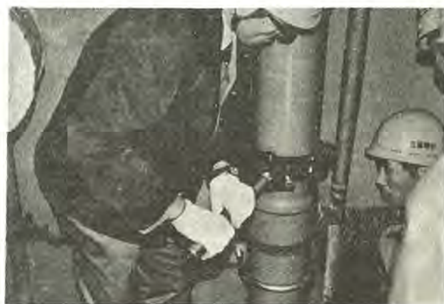
図 3. 油圧ジャッキ 据付状況
