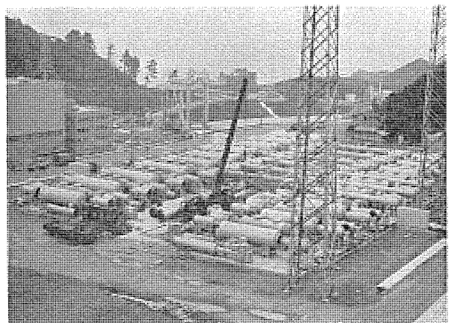
図 13. 550 kV full GIS 据付工事
