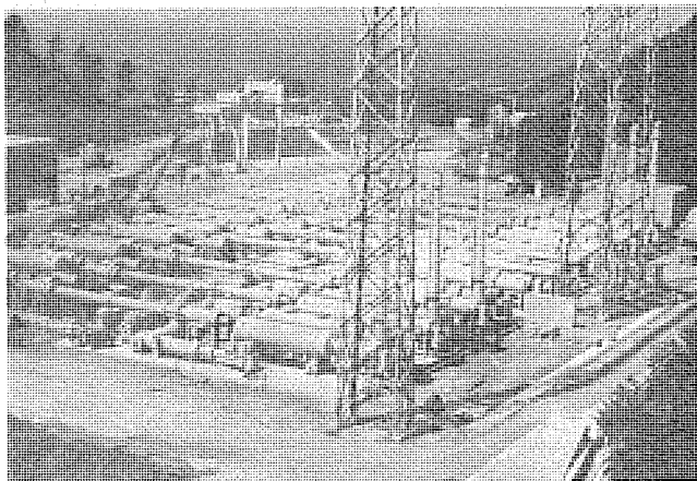
関西電力(株)大飯原子力発電所で据付工事中の 500 kV ガス絶縁開閉装置
