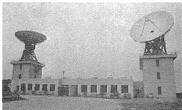
郵政省電波研究所鹿島支所に設置中の CS/BS 主局 (右側が CS アンテナ、左側が BS アンテナ)
