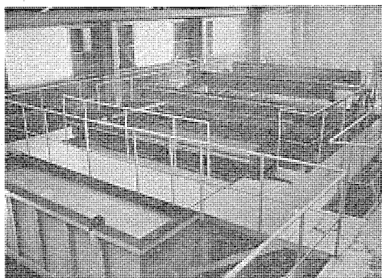
図 3. 電気浮上槽上部 (DF-150)
