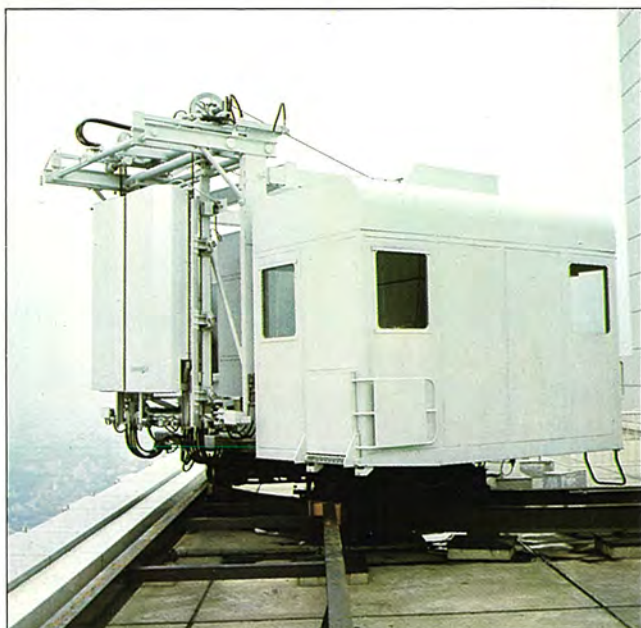
ビル清掃の省力化をはかった 新宿住友ビル納め自動窓ふきシステムのルーフ・カー (本文74ページ6-2.9参照)
