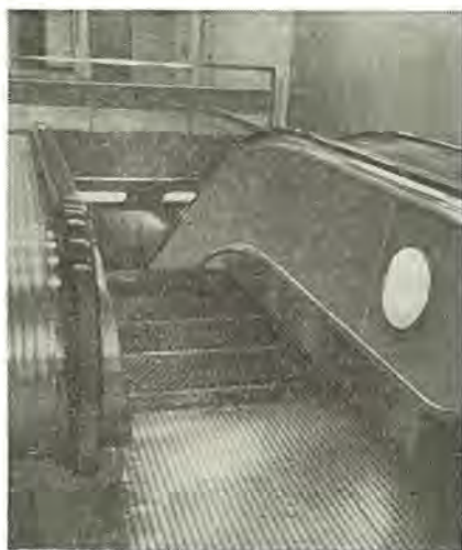
図 6. 乗降口におけるステップ水平移動距離を長くしたエスカレータ
