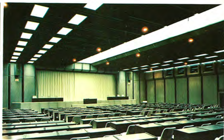
▲愛知県産業貿易会館 西館大会議場(名古屋) ルーバを付けた天井内部に40Wけい光灯トラフ形器具520台設置 ダウンライトは100W白熱灯用16台使用 机上面平均照度は400lxSCR調光装置により全灯調光できる施設である。
