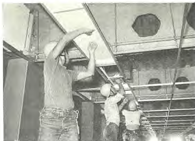
図 11. ルミ モジュールの取付け作業
