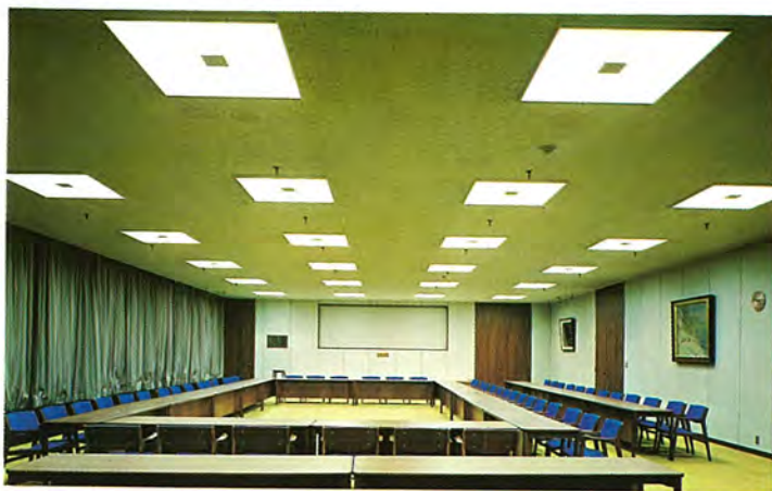
▲東京海上火災保険(株) 役員会議室 円形けい光灯40W4灯・30W4灯使用(計8灯) 下面透明プリズムガラスカバー・空調用吹出口付き埋込み形器具28台使用 机上面照度は700~850lxである。
