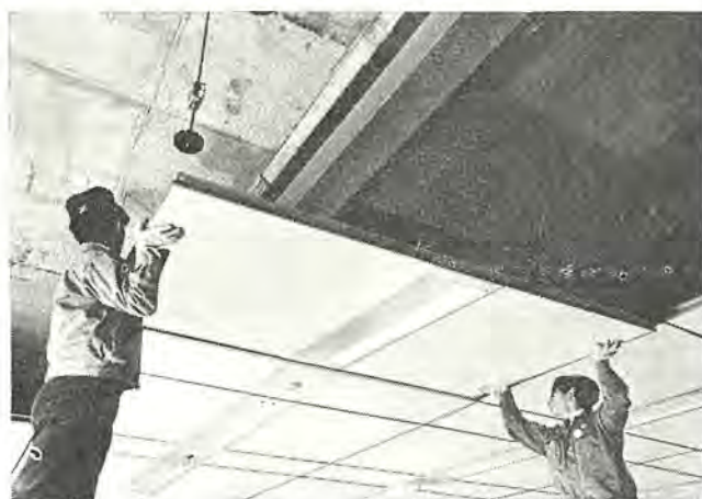
図 12. システムラインの取付け作業
