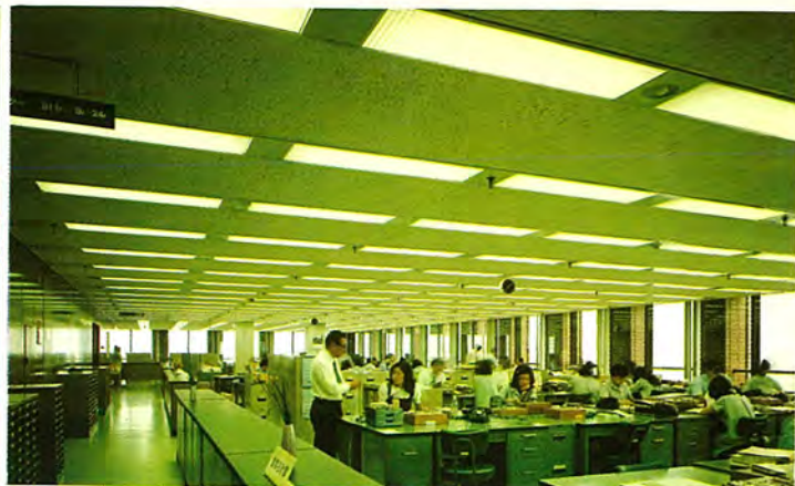
▲東京海上火災保険(株) 本館基準階事務室(東京) 40Wけい光灯2灯用アルミルーバ付き埋込み形器具使用 システムラインTバー方式を基準階1階あたり492台使用 机上面照度は1,100lxである。
