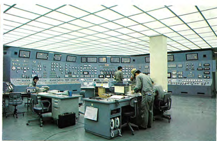
▲関西電力(株)高浜原子力発電所 中央制御室(福井) 40Wけい光灯トラフ形器具333台 20W同形器具36台によるルーバ天井照明 照度は机上面で1,175lx、制御盤の鉛直面で750~900lxとなっている。
