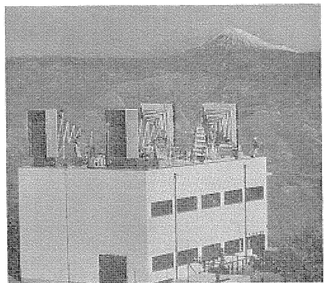
図 1. 4 GHz 帯用パスレングスレンズアンテナ Path-length lens antenna for 4 GHz band.
