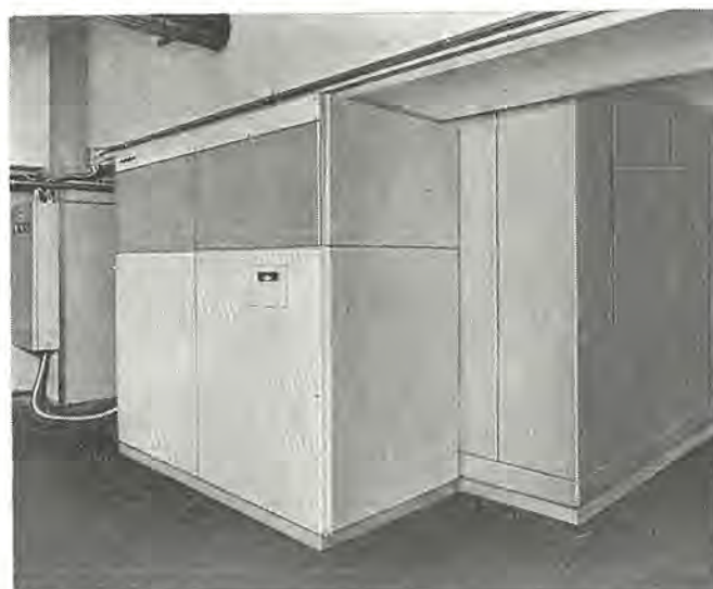
図 1. 冷凍クーリングユニット (ACS 形) の据付例 Typical setting view of cooling unit (model ACS).
