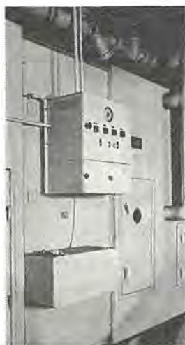
図 14. 三菱ビルヂング設置 状態 Dust collector installation at Mitsubishi Building.
