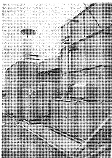
図 6. 食肉加工工場排気のオゾンによる脱臭装置 Ozonation-deodorizing plant for meat packing exhaust gas.
