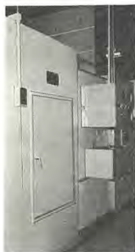
図 13. 読売新聞社設置 状態 Dust collector installation at the Yomiuri.
