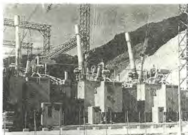
図 19. 関西電力(株)猪名川変電所納め 三相バンク 1,000 MVA 500/275/73.5 kV 単相単巻変圧器 Three-phase bank 1,000 MVA 500/275/73.5 kV (three single-phase autotransformers with U. L. T. C.) for Kansai Electric Power Co.
