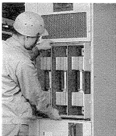
図 4.2 限流ユニット引出し状況 Current limiter drawn out.
