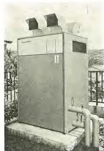
図 3.66 三菱 AE-15形蓄冷熱式冷温水ユニット施設例
