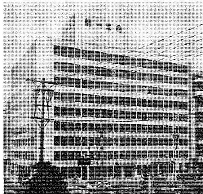
図 3.2 ダイヤグライド DC-GD エレベータ納入ビル の一例 Example of the building equipped with the DIA-GLIDE DC-GD elevator.
