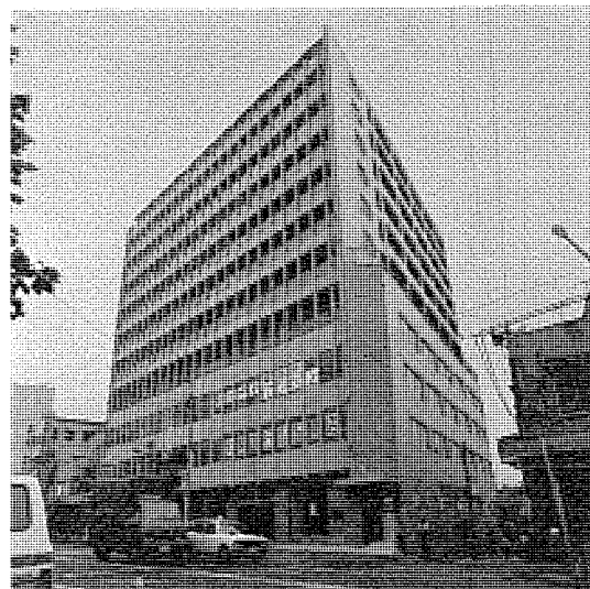
図 2.13 ダイアグライト方式エレベット納入ビルの一例 Example of the building equipped with the DIA-GLIDE ELEPET.
