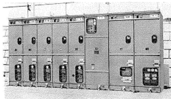
図 4.1 東京電力(株)土橋変電所設置 6.6 kV ミニクラッド 6.6 kV Miniclad at Tsuchihashi substation.
