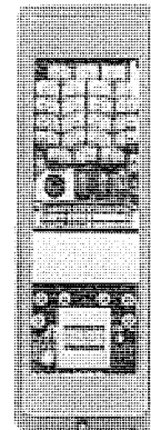
図 3.3 全静止形 回線選択保護継電装置 Solid-state selection protective relaying system.
