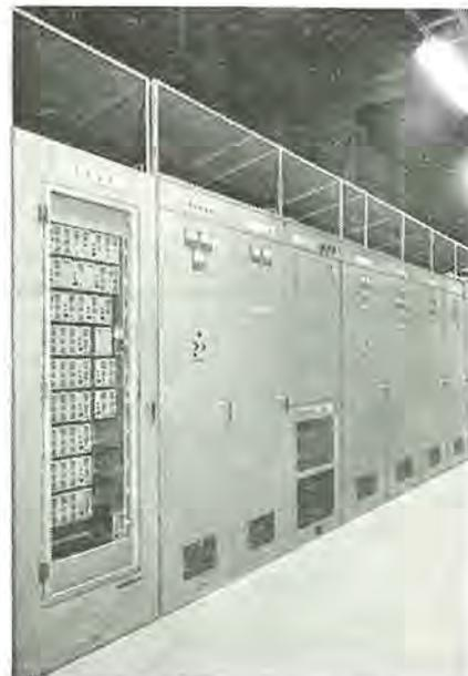
図 4.3 直流制御盤
