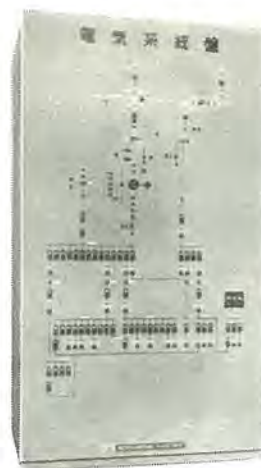
図 3.6 電気系統盤 Switch gear board.
