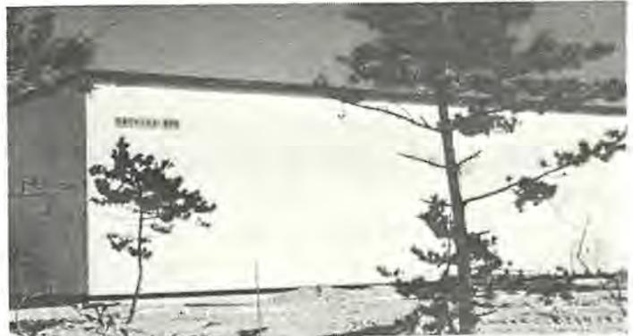
秋田製錬(株) 納め 154 kV 全天候形閉鎖配電盤
