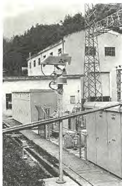
図 6.7 テレビカメラ・送信装置外観 Exterior view of TV camera and ITV-transmitting terminal equipment.
