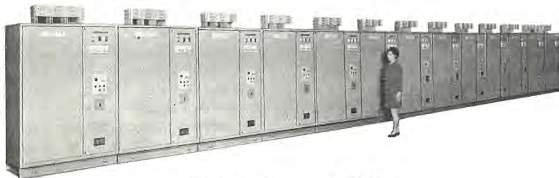
図 1.1 AC制御サイリスタ装置の列盤構成 Arrangement of AC control thyristor converter.
