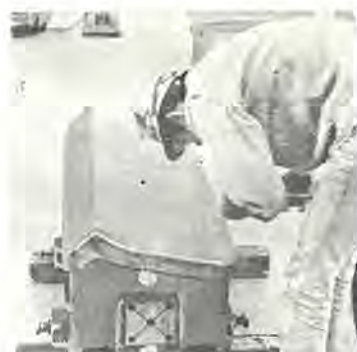
図 6.1 分割部、噴出、吸引未加工部研削作業 Hand finishing after EDM.
