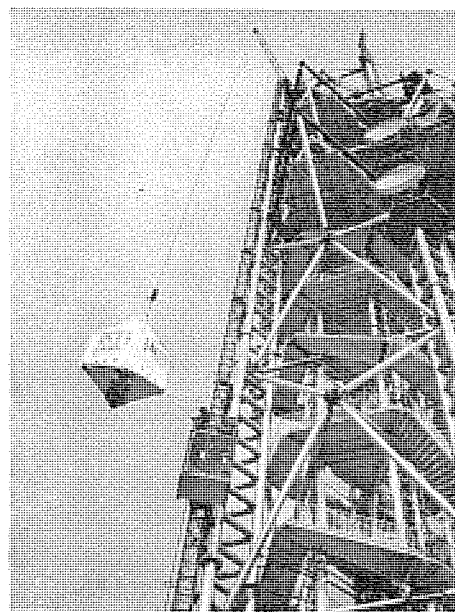
図 5.7 タワーへのつり上げ搬入 Installation of elevator cage.
