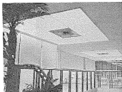
図 17. 15 電通興産ビル 光天井 DP-34 F デラックスパネル 8 枚 (FLR 40×38 本入り)
