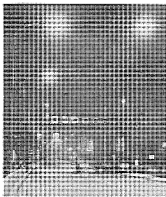
図 17. 43 首都高速道路1号線 HP-321 (HF 400) 建設省 KSC-4 形 64 台 ポール 2 E 10 A 傾斜角 5 度 本線標準部分 平均照度 45.3 lx 本線標準部分 均斉度 (最小/平均) 1/2.44 本線標準部分 器具取付間隔 30 m
