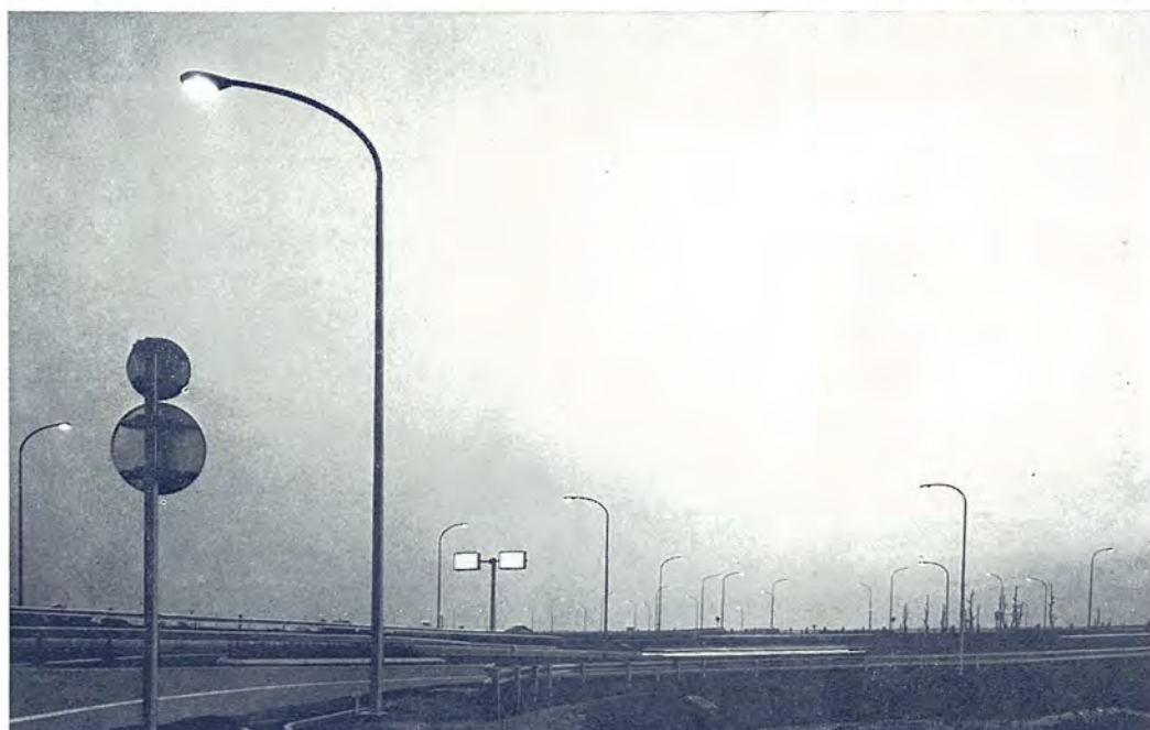
東名高速道路焼津インター チェンジ 建設省形KSC形 ハイウェイ用水銀灯 (700Wおよび400W使用) Tomei Express Way, Yaizu interchange type KSC high- way mercury lamp (700W and 400W)
