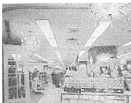
図 17. 37 岡田屋横浜店 埋込形 FB 4702 D-R (FLR 40×2) 2 連続器具 平均照度 1,000 lx
