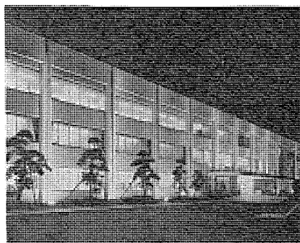
図 17.25 三菱重工業(株) 川崎自動車製 作所の壁面照明 HL-310 (HR 400-N) 14 台
