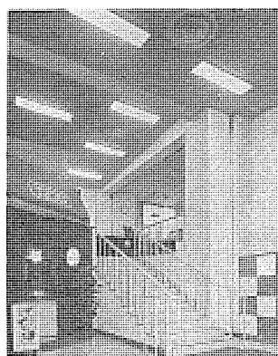
図 17. 36 丸愛百貨店 (東京) 半埋込形 EY 4702-R (FLR 40× 2) LV 902 (電球 IL 60×3) LP 701 C (IL 100) 床面平均照度 300 lx
