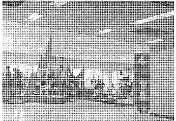
大阪 マーチャндаイズ マートビル(OMM) 三菱 M 400-BOC ランプによる大展示場の照明 Lighting of a large display room with Mitsubishi M 400-BOC lamps, Osaka Merchandise Mart Building.
