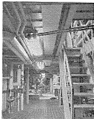
図 17.24 (b) 関西電力(株) 三宝火力発電所 ボイラー室 安全増防爆形 FWE -412 R (FLR 40 × 2) 19 台
