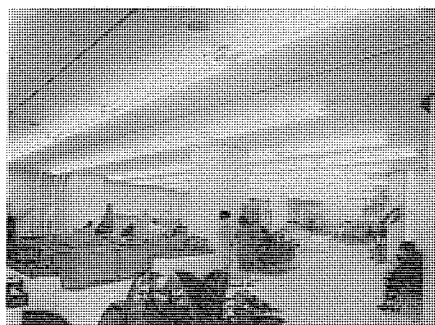
図 17. 16 三菱信託銀行横浜西口支店 営業室 じか付け形 FT 11032 R (FLR 110 H×2) 4 連続器具カウンター面平均照度 2,000 lx
