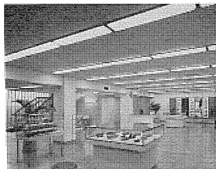
図 17. 19 三菱重工業(株)川崎自動車製作所 半埋込形 FY-4702 R (FLR 40×2) 連続器具 床面平均照度 400 lx
