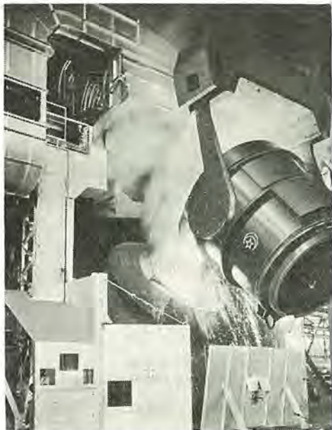
図 2.1 転炉溶銑装入状況 Charging hot metal in converter.
