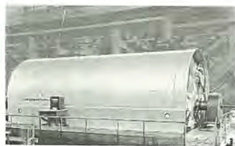
図 1 工場試験中の鹿島北共同発電(株)向け 125,000 kW タービン 発電機
