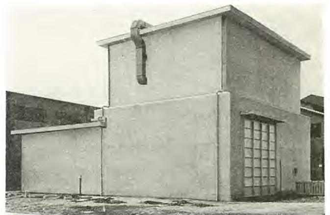
図 3.12 MCF 建屋全景 Mitsubishi critical facilities.
