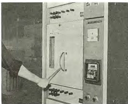
図 3.10 断路機構 Disconnecting mechanism.
