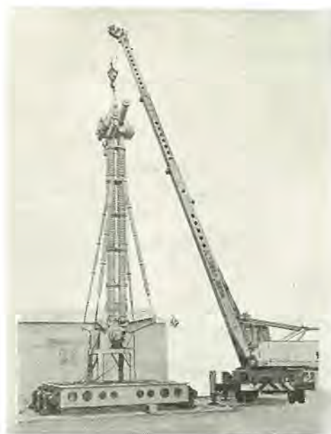
図 4.1 振動試験状況 View of vibration test.
