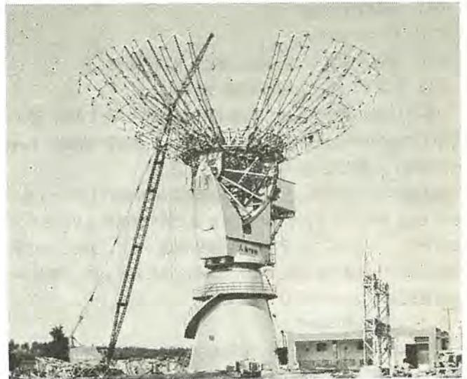
図 3.14 主反射鏡骨組の組立て
