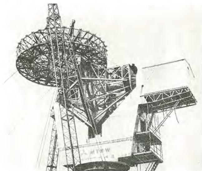
図 3.13 主反射鏡リングのつり上げ
