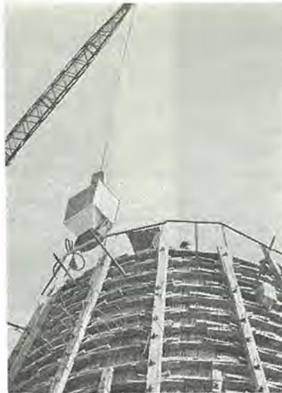
図 3.4 コンクリート打込み作業
