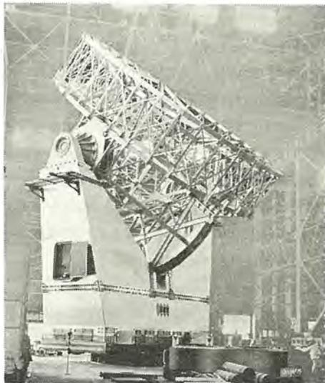
図 4.19 回転構造部の工場内組立
