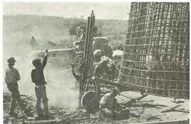
図 3.2 インジェクション工事用ボーリング作業
