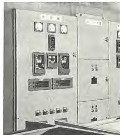
図 3.9 力率改善用コンデンサ自動制御装置 Automatic control equipment for power factor improving condenser.
