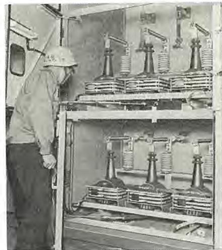
図 3.2 EV-2 X 形計器用変圧器 22 kV 級
