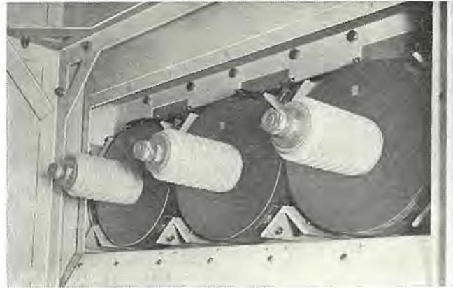
図 4.1 (キュービクル内蔵) ブチルゴム変流器
