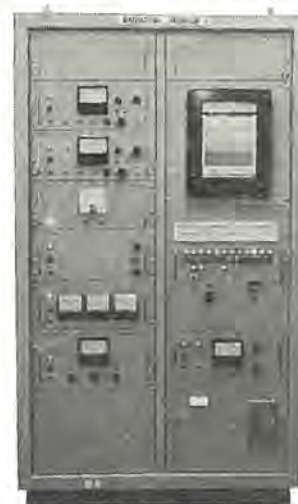
図 3.10 放射線モニタ盤 Radiation monitoring board.
