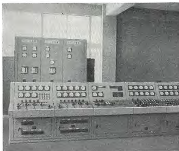
図 3.3 監視制御盤および計器盤 Control desk and instrument panel.
