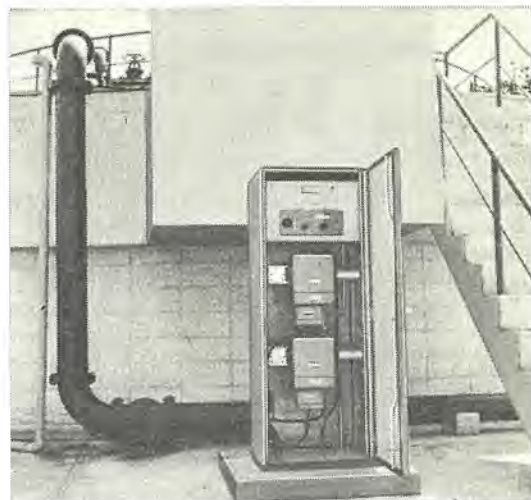
図 3.10 現場計器盤 (その 2) Local instrument panel.
