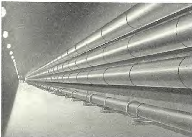
図2 KB形離相母線 16.5 kV 5,000 A BIL 125 kV
