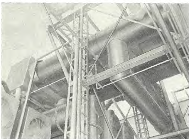
図1 WB形離相母線 19 kV 17,000 A BIL 150 kV
