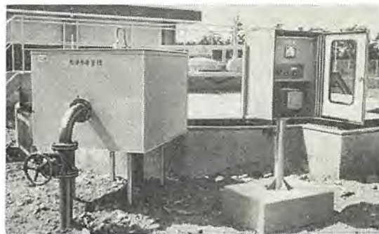
図 3.11 現場計器盤 (その 3) Local instrument panel.
