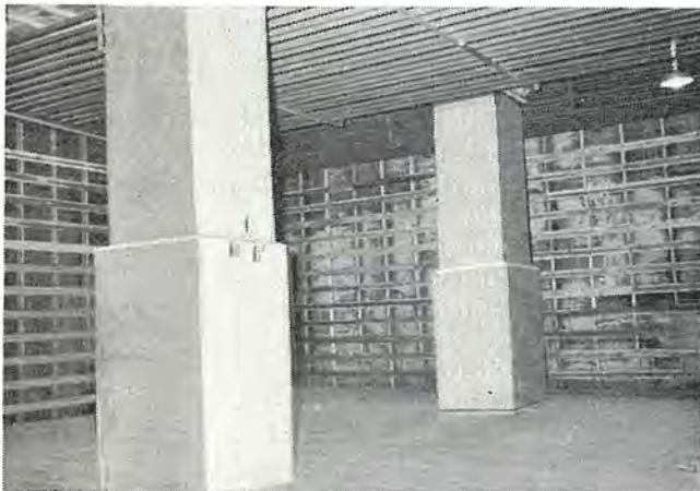
図 3.14 ウォークイン形冷蔵庫 (自然対流形方式) Walk-in type refrigerating warehouse (Natural flow).
