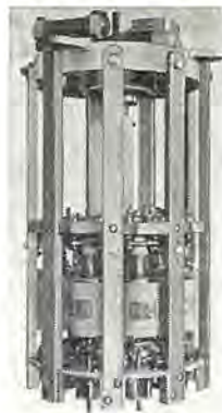
図 6.2 切換開閉器 中身 Diverter contents.
