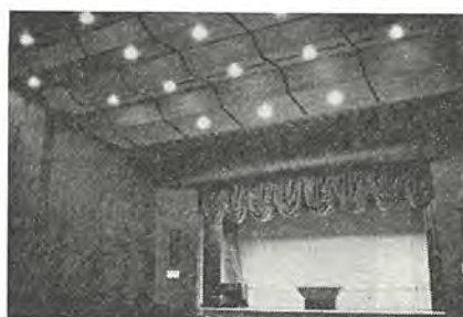
図 15. 26 尼崎市立勤労福祉会館 3 階大ホール IL-300 W ダウンライト 6 台×8 列=48 台 ただし調光式 IL-20×2 禁煙表示灯 Saloon of Amagasaki city Labor and Welfare Assembly Hall.
