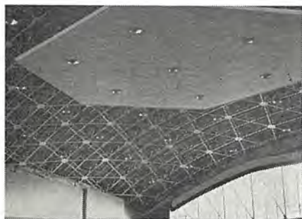
図 15. 43 関西電力総合体育館 HF 400 SW 32 灯 IL 500 24 灯 平均照度 350 lx 取付高さ 平均 11 m Gymnasium of Kansai Elec. Power.
