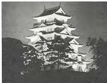
図 15. 65 福山城 HF 1000 投光器 19 台 HF 700 投光器 6 台 公園内 300 W×15 台 平均 70 lx Fukuyama Castle.
