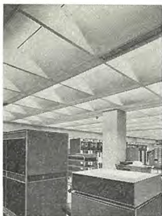
図 15. 20 東京海上火災保険電子計算機室 40 W×1 空調つき 照度 1000 lx Electronic computer room lighted with 40 W lamps the Tokyo Marine and Fire Insurance Co.
