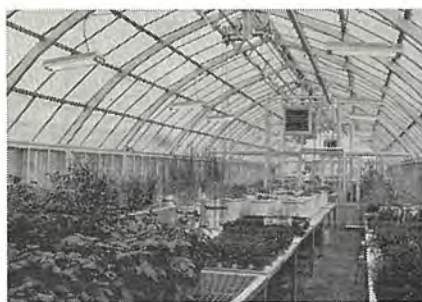
図 15.33 農林省北海道農事試験所温室 防湿形 20 W×2 灯用特殊器具 100~200 lx Green house of agricultural experiment station.
