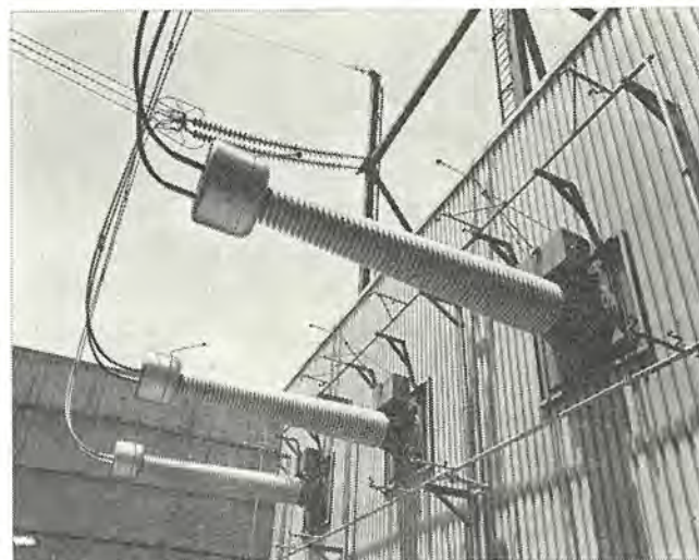
図 3.23 287.5 kV, 4,000 A 耐塩害用壁抜き ブッシング 287.5 kV, 4,000 A salt contamination proof wall-bushing.
