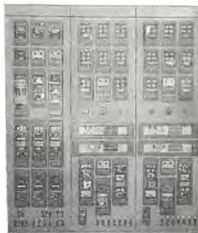
図 3. 59 静止形リレーの組合せによる搬送保護継電装置盤 Carrier protective relaying pannel with static relays.
