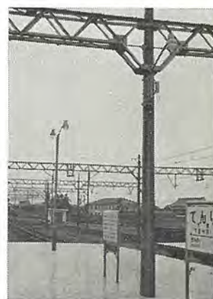
図 15. 48 近鉄天理駅 HP 107 H 形 HF 100 × 1 × 2 灯 Tenri Station Kintetsu.
