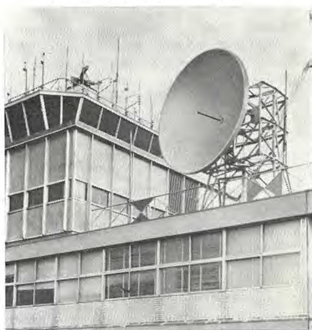
図 11.15 羽田局設置 4 mφ パラボラ空中線 Parabolic antenna with 4 meters diameter of Haneda Air Port.
