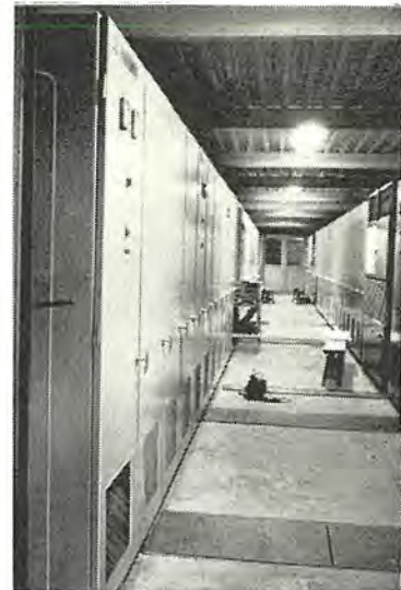
図 8.14 川崎製鉄(千葉) ETL のサイリスタ室 (ユニテア3台で冷却している) Thyristor room of Kawasaki Steel Corp.
