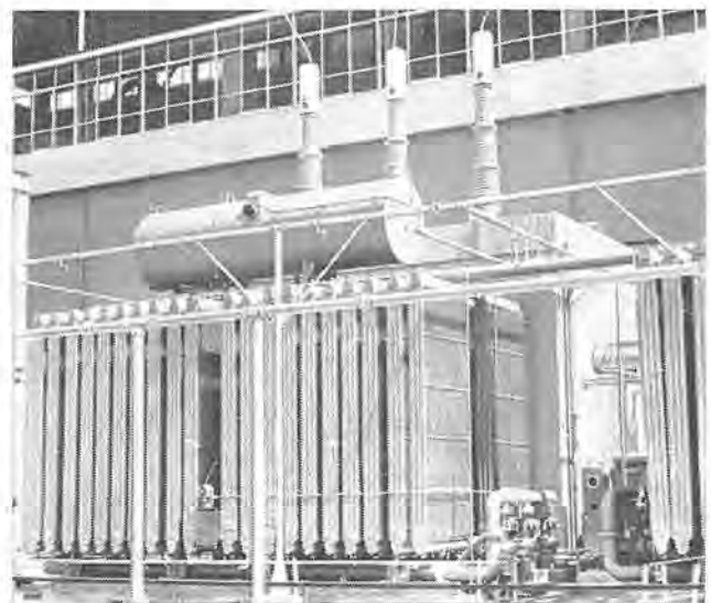
図 3. 3 九州電力唐津 P/S 納め三相 170 MVA 225/17 kV 変圧器（コンクリート防音壁使用の低騒音形） Three-phase 170 MVA 225/17 kV transformer for the Kyushu Electric Co. (Low noise level with the shelter of ferro-concrete).
