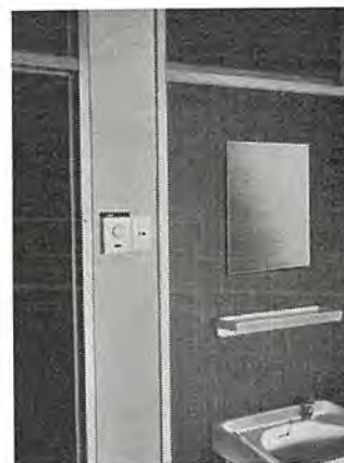
図 15.39 小形調光器実施例 東北大学医学部病院 Example of small dimner equipment Tohoku University Hospital.
