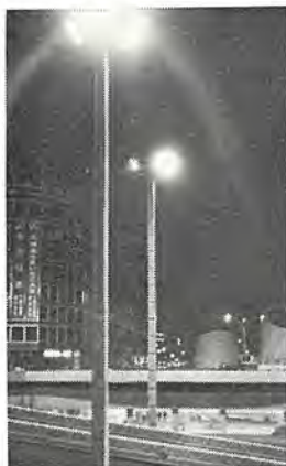
図 15. 50 新宿西口広場 16 kW × 6 灯 キセノン灯照明 West side plaza of shinjuku Station.
