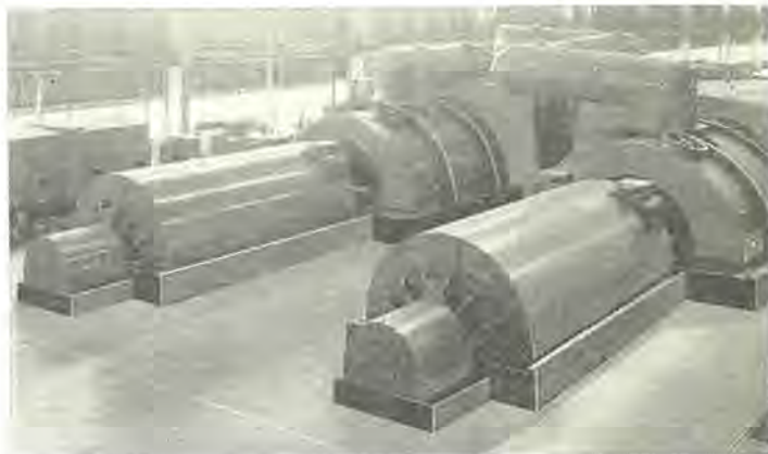
図 2.1 現地で試運転中の東京電力五井発電所納め 2 \times 224,000 kVA, 3,000 rpm 内部冷却 タービン 発電機 (クロスコンパウンドユニット) 2x224,000 kVA, 3,000 rpm hydrogen inner-cooled turbine generator for the Tokyo Electric Power Co., under trial run. (cross-compound unit)
