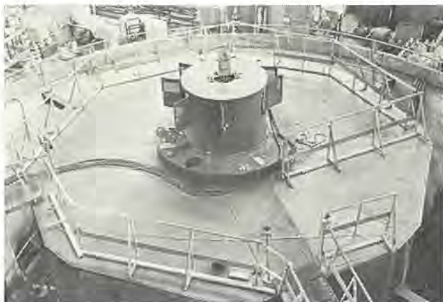
図 2.19 台湾電力下達見発電所向け 100 MVA 水車発電機 100 MVA water wheel generator for Lower Tachien Hydroelectric Project, Taiwan Power Co.
