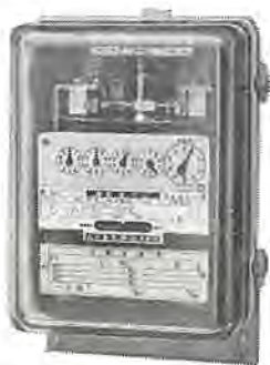
図 3.3 YUS-51 形電力量計 Type YUS-51 watt-hour meter.
