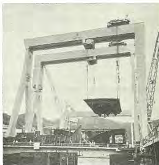
図 2.3 橋形クレーン Fig. 2.3 Gantry crane.
