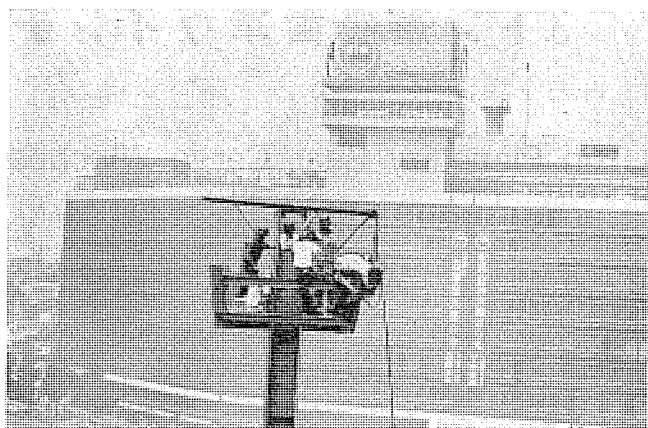
図 5.5 キセノン投光器の取付工事 Fig. 5.5 Installation of the xenon projector.
