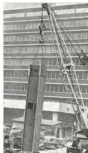
図 5.1 照明タワー (下部) のつり上げ Fig. 5.1 Lifting the lower part of lighting tower.
