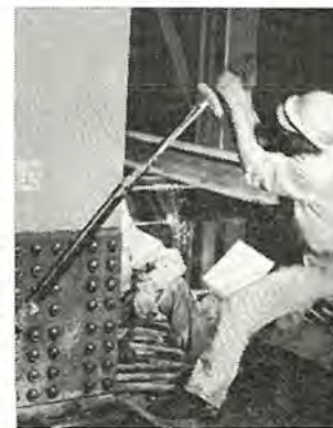
図 5.4 照明タワー (上部) と (下部) の結合 Fig. 5.4 Connection of the upper and lower part of the lighting tower.
