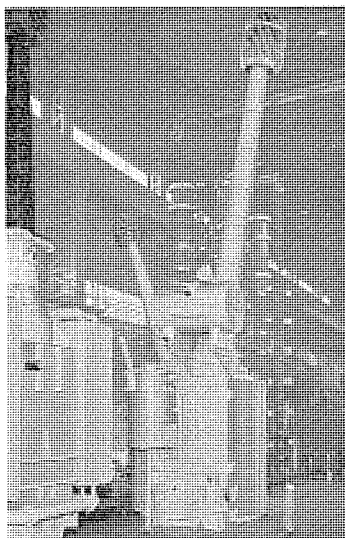
図 1.1 500 kV 10 MVA 変圧器外観 Fig. 1.1 500 kV 10 MVA transformer.
